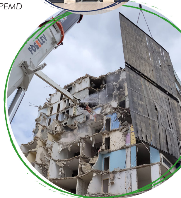
CLAMART Démolition de 351 logements
